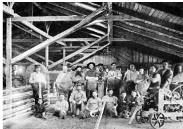
Esbjerg Rebslageri opstod også på initiativ af Ditlev Lauritzen. I 1909 blev virksomheden til et aktieselskab ved navn Esbjerg Tovværksfabrik. I dag er Tovværksfabrikken kendt som hjemsted for bl.a. svømmestadion, fitnesscenter og biograf.
